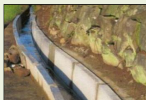
素堀り水路からの更新
