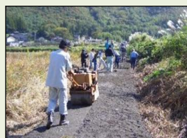
未舗装農道の舗装
