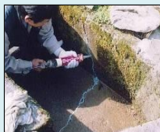
ひび割れの補修
