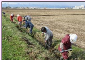
水路の泥上げ
