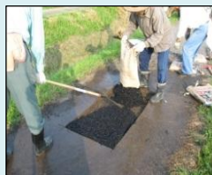
農道の部分補修
