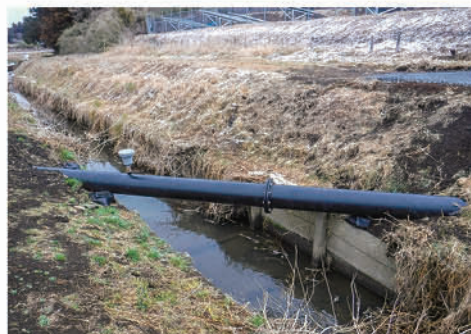
県単事業による水管橋の更新
