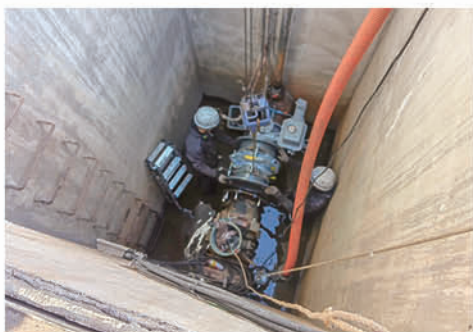
水利施設管理強化事業による制御弁交換の様子
