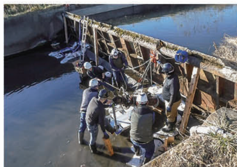
土地改良施設維持管理適正化事業による ゲート補修工事の様子
