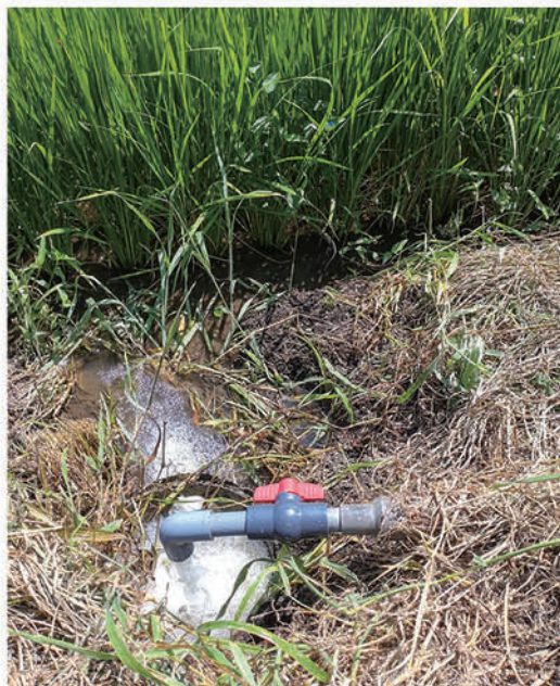
プラスチック製蛇口の様子
