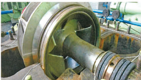
基幹水利受託事業による揚水ポンプの点検整備
