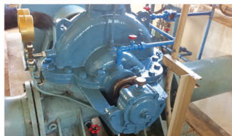
県単土地改良事業によるポンプの更新
