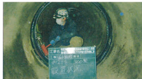
維持管理適正化事業によるパイプラインの補修
