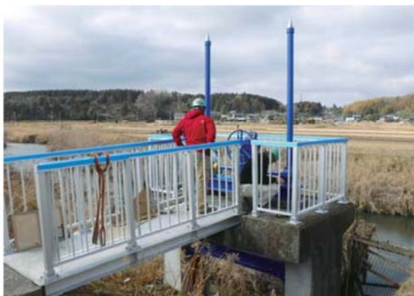
維持管理適正化事業によるゲート補修
