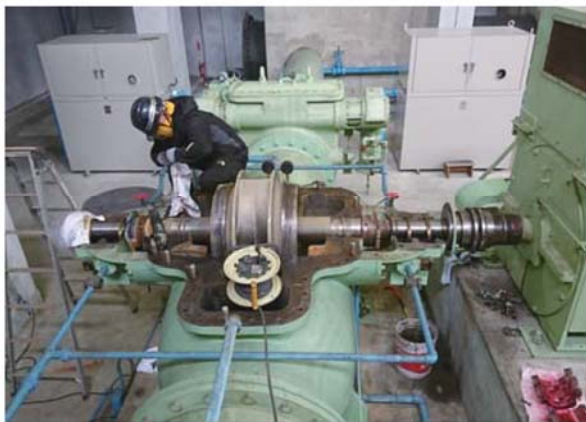
基幹水利管理受託事業によるポンプ設備補修
