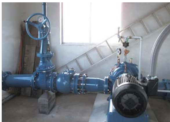
維持管理適正化事業によるポンプ設備補修
