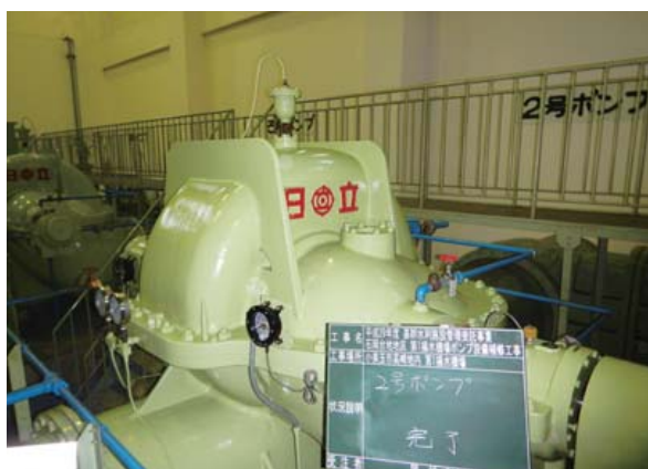
基幹水利管理受託事業によるポンプ設備補修
