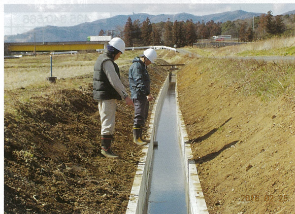
多面的機能支払交付金による水路整備
