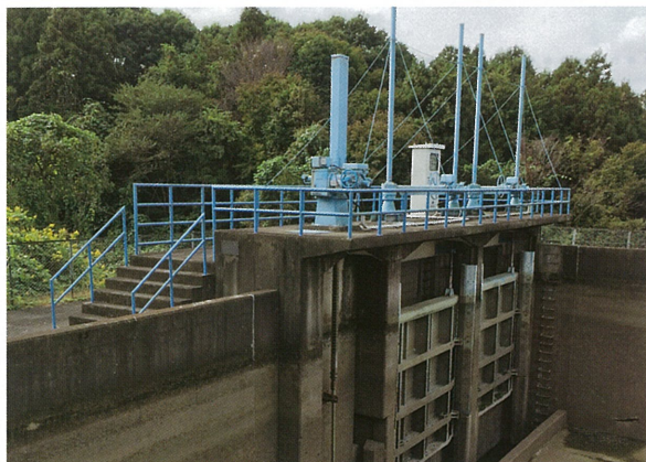
基幹水利管理受託事業によるゲート補修
