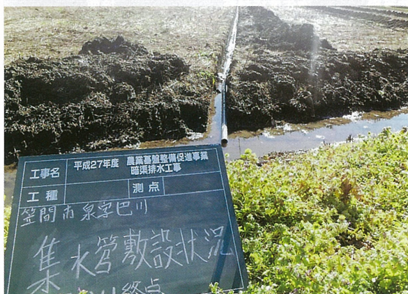
農業基盤整備促進事業による暗渠排水工事
