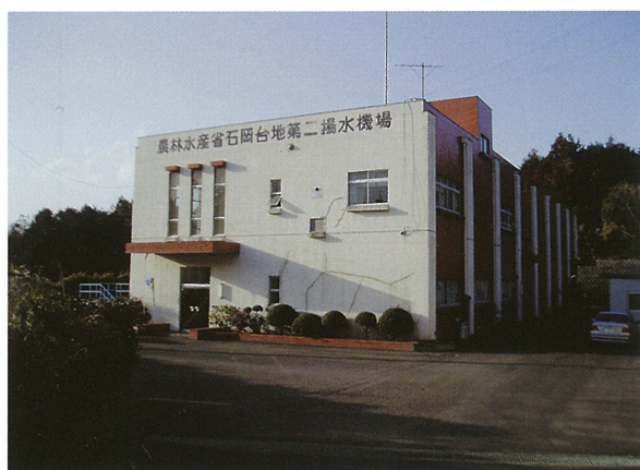
第2揚水機場建屋（小美玉市中延）
