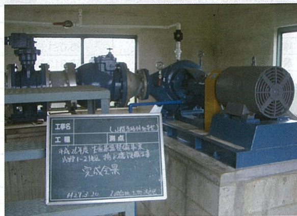
維持管理適正化事業によるポンプ設備更
