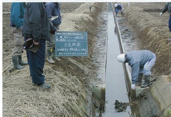
東野寺地区 排水フリーム布設工事
