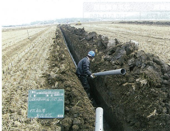
農業基盤整備促進事業を利用した暗渠排水工事
