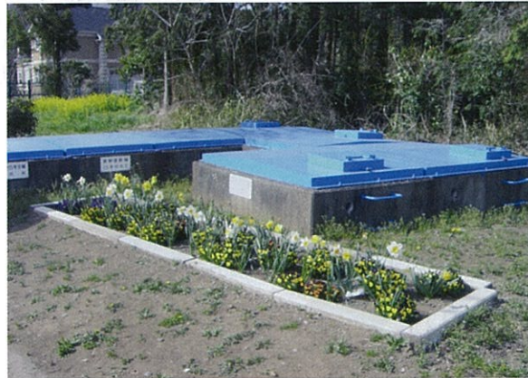
国営造成施設管理体制整備促進事業による分水施設の環境整備
