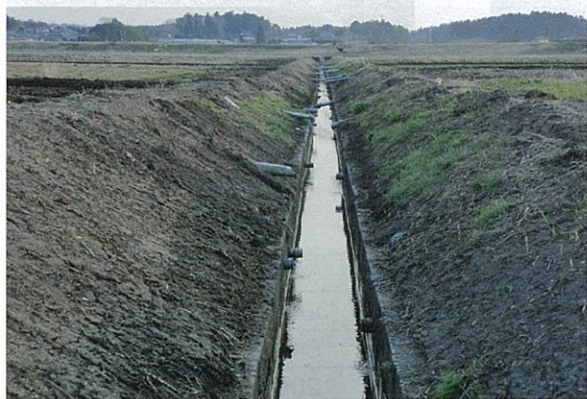
染谷地区 水路護床工事
