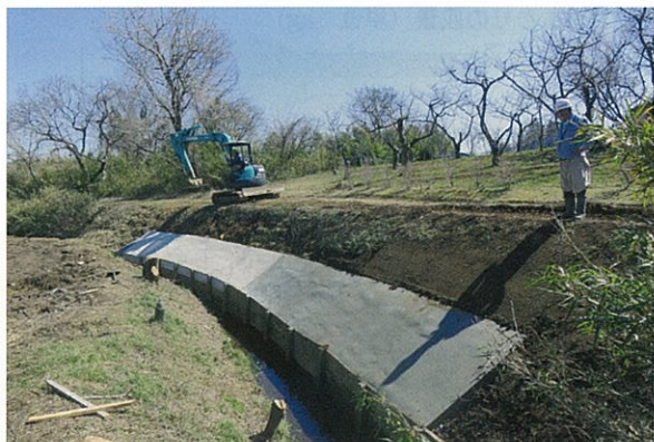
根当地区 水路法面補修工事
