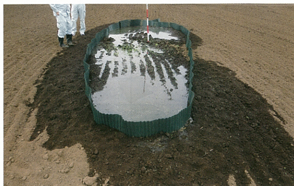
畑の中に起きた漏水（千代田幹線本管1200mm）
