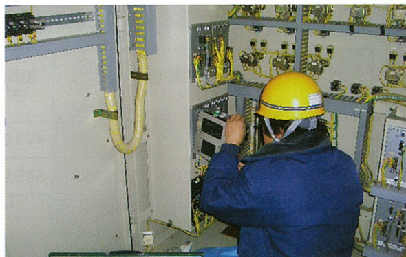
分土工制御装置基盤の交換
