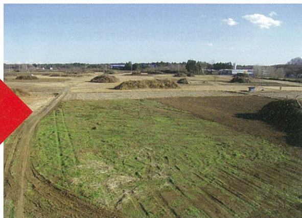
工事中：伐採した樹木をチップ化し集積。 今後区画整理工事に入ります。
