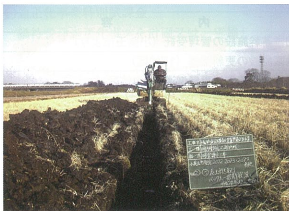
③水田を汎用化するための暗渠排水工
