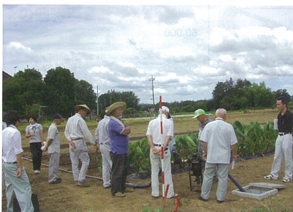
圃場に設置された蛇口にかん水チューブを接続
