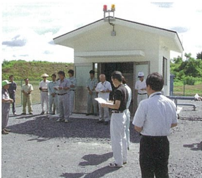
完成した畑地かんがい用機場の通水式の様子
