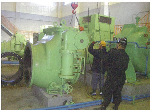
基幹水利施設管理受託事業による仕切弁のオーバーホール作業（国営揚水機場）
