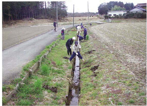
農地・水保全管理による水路清掃作業
