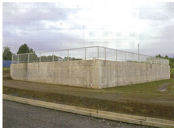
畑地かんがい用吸水槽の設置
