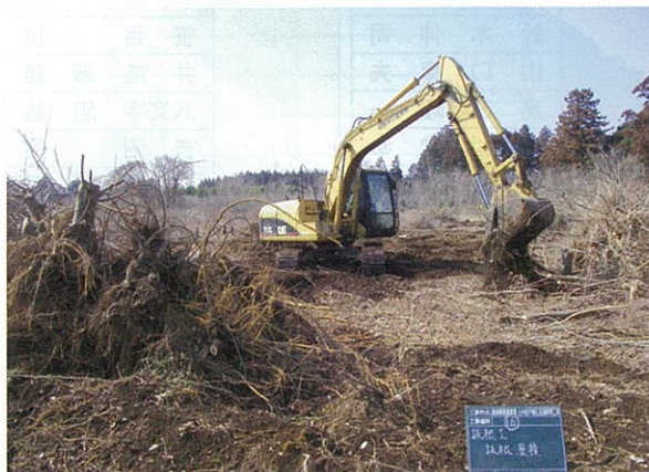
樹木の伐採除去作業
