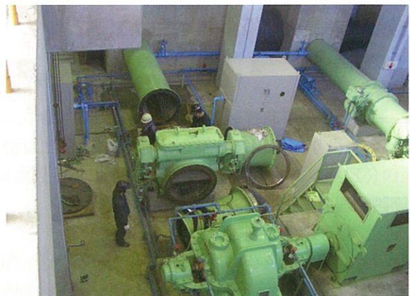
基幹水利施設管理受託事業による仕切弁のオーバーホール作業（国営揚水機場）
