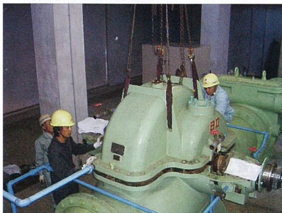
基幹水利施設管理受託事業による国営施設のポンプ補修作業
