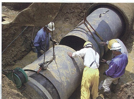
用水管の交換作業
